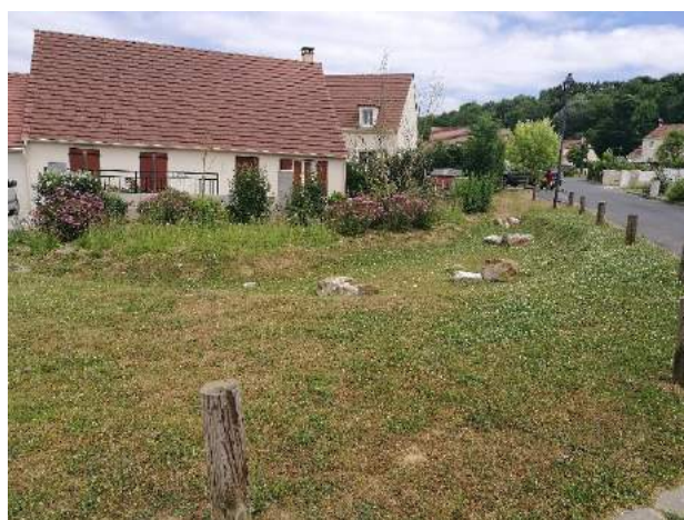
Fig.4 / Ouvrage de gestion alternative des eaux pluviales
