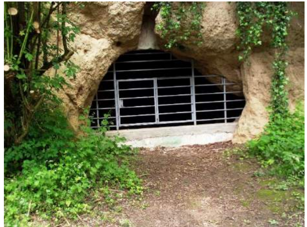
Fig. 8 / Le barreaudage de la grotte du refuge du parc de Géresme ©VilleDeCrépyEnValois
