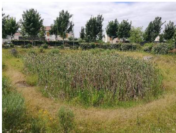
Fig. 5 / Mare de récupération des EP en aval d'un lotissement ©MarcBarra
