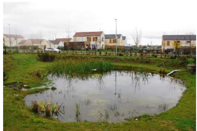
Fig. 3 / Bassin d'infiltration, lotissement sans réseau pluvial. ©VilleDeCrépyEnValois
