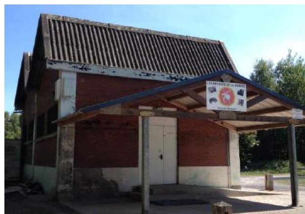
Fig. 18/ Bâtiment conservé pour les Archers de la Sambre. ©FlorentCHAPPEL
