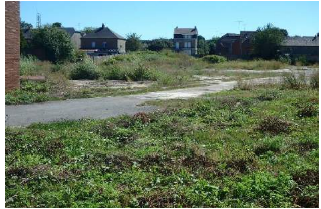
Fig. 4 / La friche Miroux avant la deuxième phase de démolition. ©CAMVS
