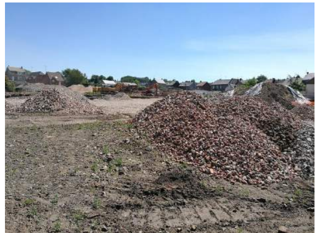
Fig. 5 / La deuxième phase de démolition de la friche Miroux en cours. ©MarcBarra
