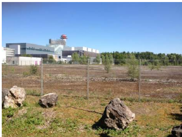
Fig. 14/ Nouvelle centrale et site de la future ferme solaire. ©FlorentCHAPPEL
