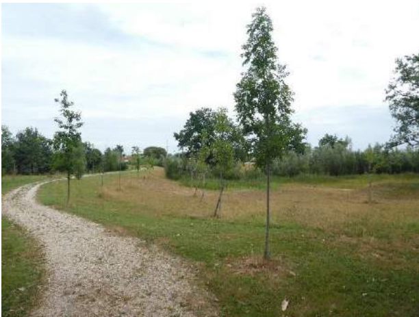
Fig.3 / Bassin de rétention d'InnoProd. ©GillesLecuir
