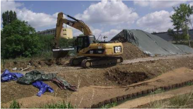
7. Chantier en cours lors de la visite. / Micand A., Plante & Cité
