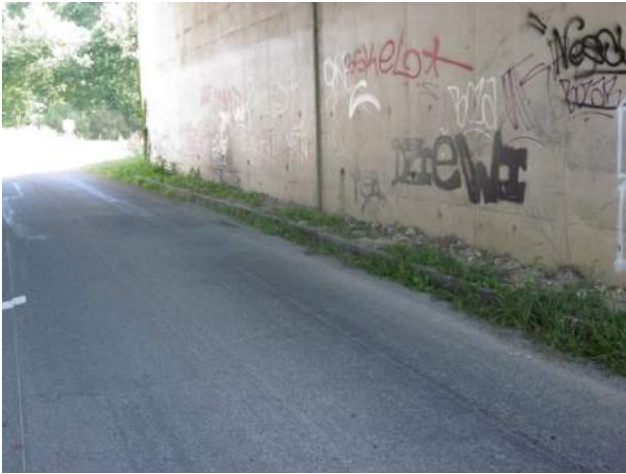
Fig. 6/ Passage à faune – Pont Roncerais sous RN137. ©MarieWagner
