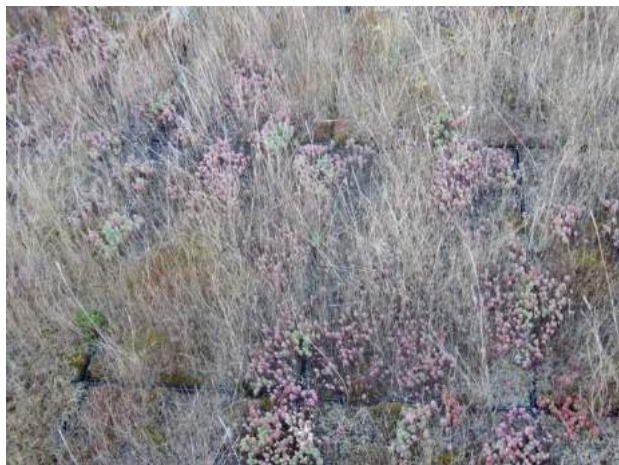
Fig.9 / Toiture végétalisée composée de barquettes sédum ©MarieWagner
