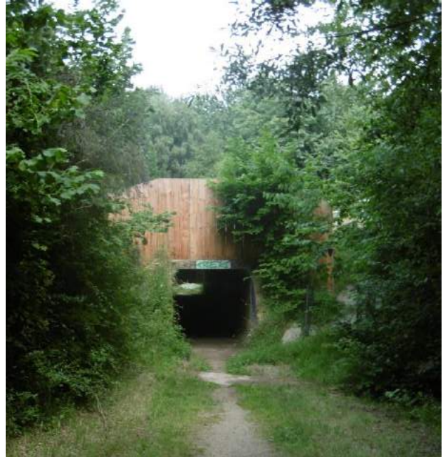
Fig. 7/ Passage à faune Pont des Loges. ©MarieWagner
