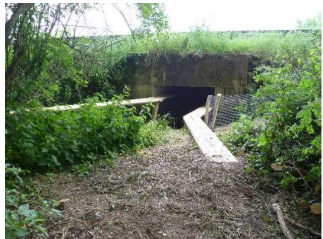
Fig. 5 / Passage à faune sous la RD82 à Melesse - Passage inférieur dans un pont cadre où passe le ruisseau du Quincampoix. ©CCValdilleAubigné
