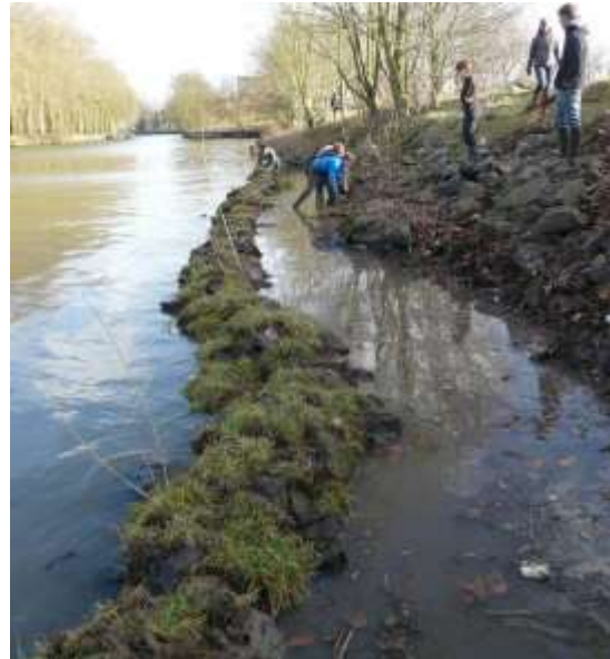
Figure 21 : chantier de renaturation de berge sur le secteur des pyramides ©Ville de Lille
