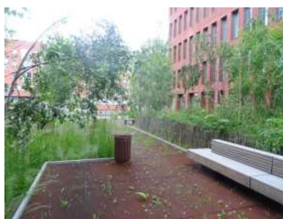
Figure 7 : Caillebotis du square Ada Lovelace permettant l'infiltration d'eau dans le sol ©Florian Fournier
