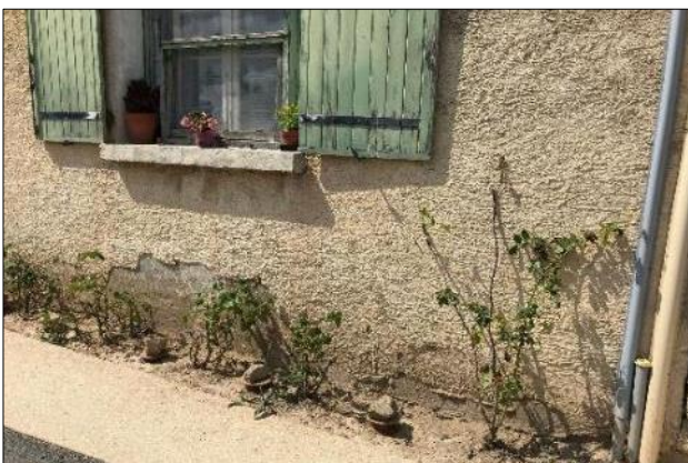
Figure 6. Plantation de végétaux en pied de mur. © Stéphanie Garrido
