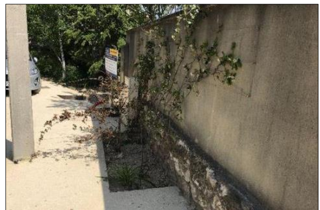
Figure 7. Plantation de végétaux grimpants en pied de mur grâce à l'installation d'une fosse © Stéphanie Garrido
