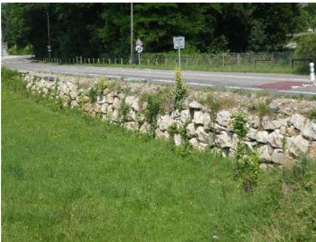
Fig.X/Haie devant un muret de soutènement en pierre sèche, sur une parcelle privée pâturée ©GillesLecuir
