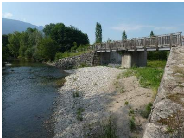
Fig.X / Bras de décharge de la Laysse ©Gilles Lecuir
