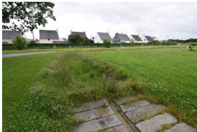
Figure 6. Noue du parc-jardin des espaces verts
