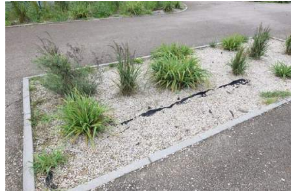
Figure 18. Gravier reposant sur un géotextile biodégradable. Le choix du Carex planté a pour but de rappeler celui présent dans la vallée du Gouëdic, et de diminuer l'entretien des massifs.
