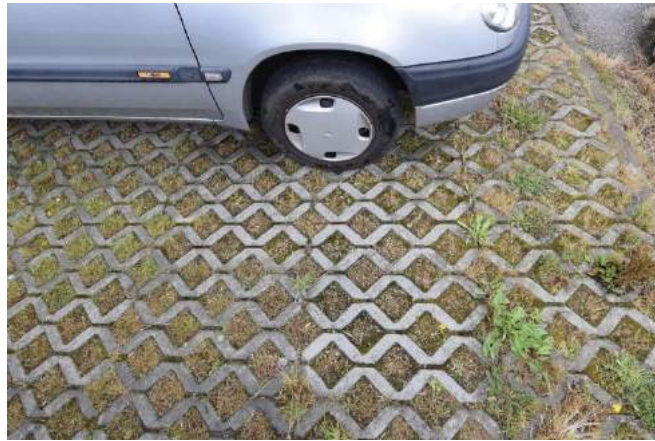
Figure 7. Parking perméable composés d'alvéoles de béton
