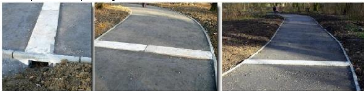
Écoducs dit « lombriducs », destinés à permettre aux vers de terre et à d'autres invertébrés ou micromammifères de traverser ce chemin de promenade. Dans ce passage en forme de U renversé, la terre d'origine n'a pas été touchée ni damée durant le chantier © Florent Lamiot
