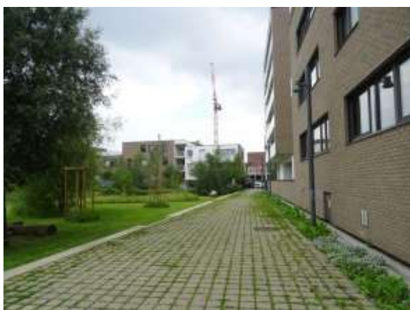
Figure 6: Pavé enherbé du cheminement piéton pour limiter l'artificialisation ©Florian Fournier
