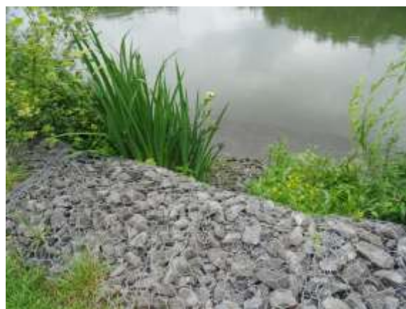
Figure 11: Berges réaménagées le long de la Deûle avec des banquettes immergées et différentes strates de végétations propices à la biodiversité ©Florian Fournier
