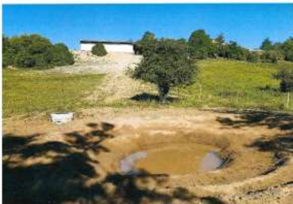
Mare en construction, centre équestre © Mairie d’Albi
